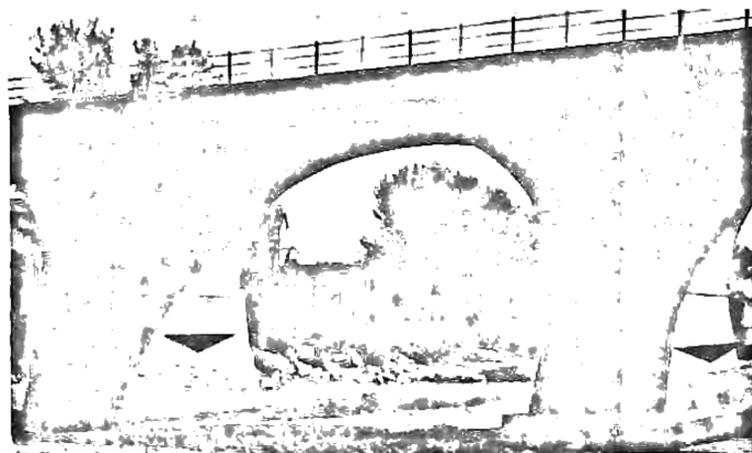
Foto 2: il ponte di Borgo Tossignano visto dal lato valle: evidente lo scalzamento dei piloni, soprattutto a destra
